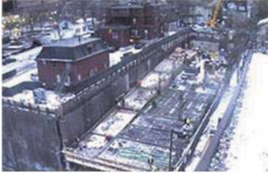
Fig.6. Losa de cimentación de un edificio de 10 niveles.
