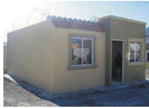
Fig.7. Casas de concreto en México.
